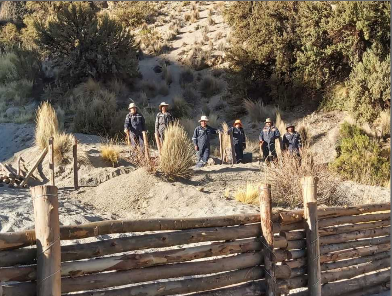
Construcción de obras de control de torrentera en Presa Ñoqueta
